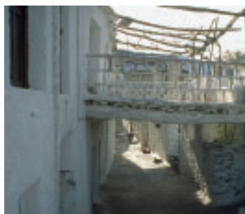
Construcción típica de La Alpujarra
