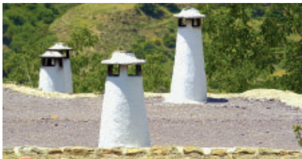
Tejado de launa con chimeneas
